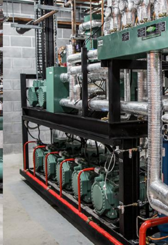
グリーンウェイビレッジ店舗で稼働するトランスクリティカルCO 2 ラックシステム
