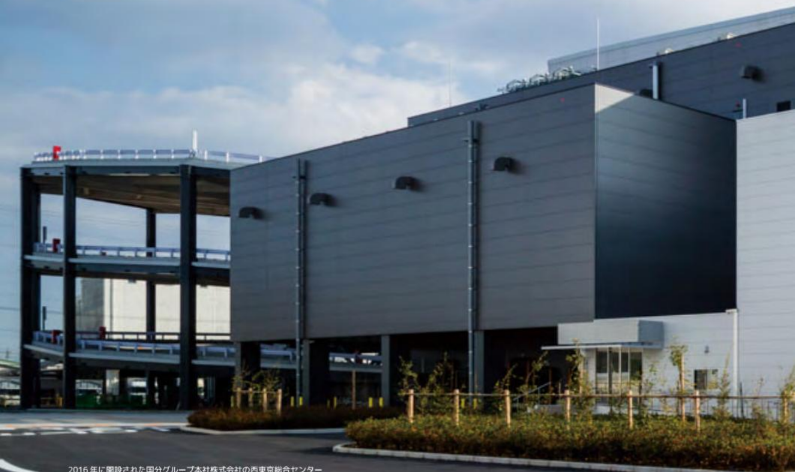
2016年に開設された国分グループ本社株式会社の西東京総合センター
