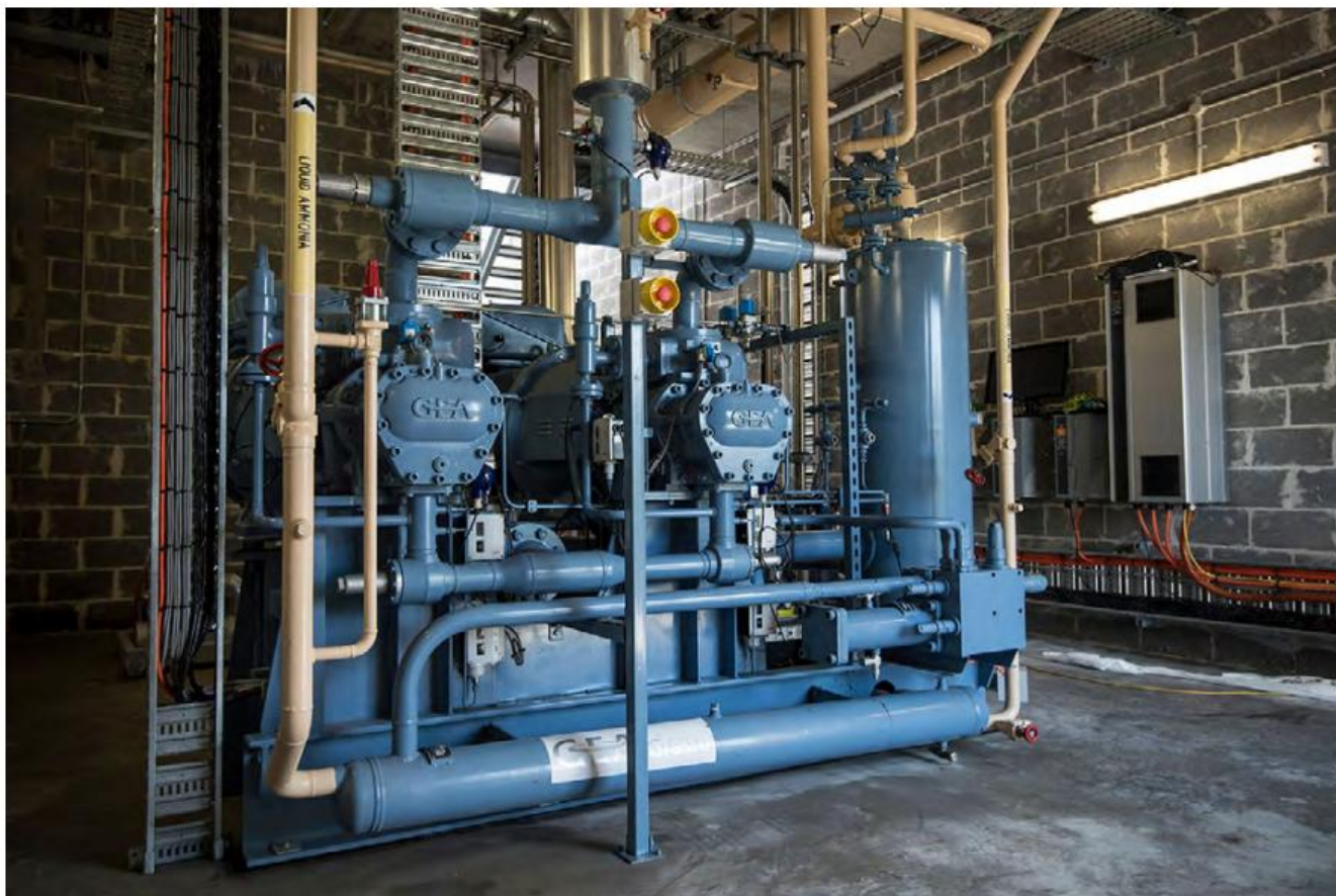
Fung Lea Food Pty. Ltd. の採用したアンモニア /CO 2 カスケードシステム
