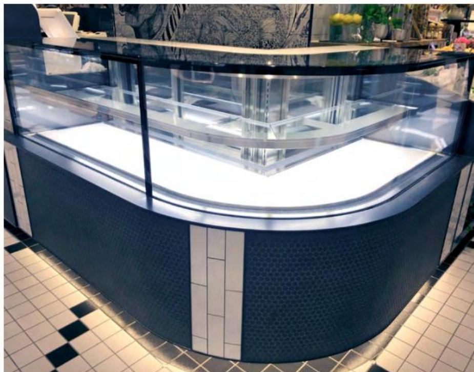
地下 2 階の売り場フロアに設置された、国内初の CO 2 水冷式冷凍機内蔵型ショーケース
