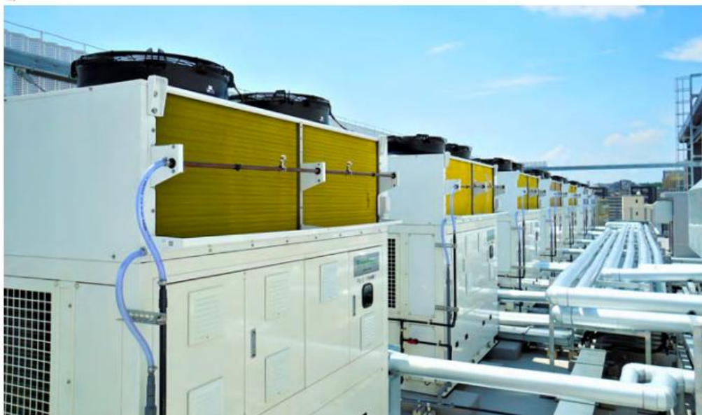
2/ センター屋上に設置された 日本熱源システム製 CO 2 冷凍機「スーパーグリーン」
