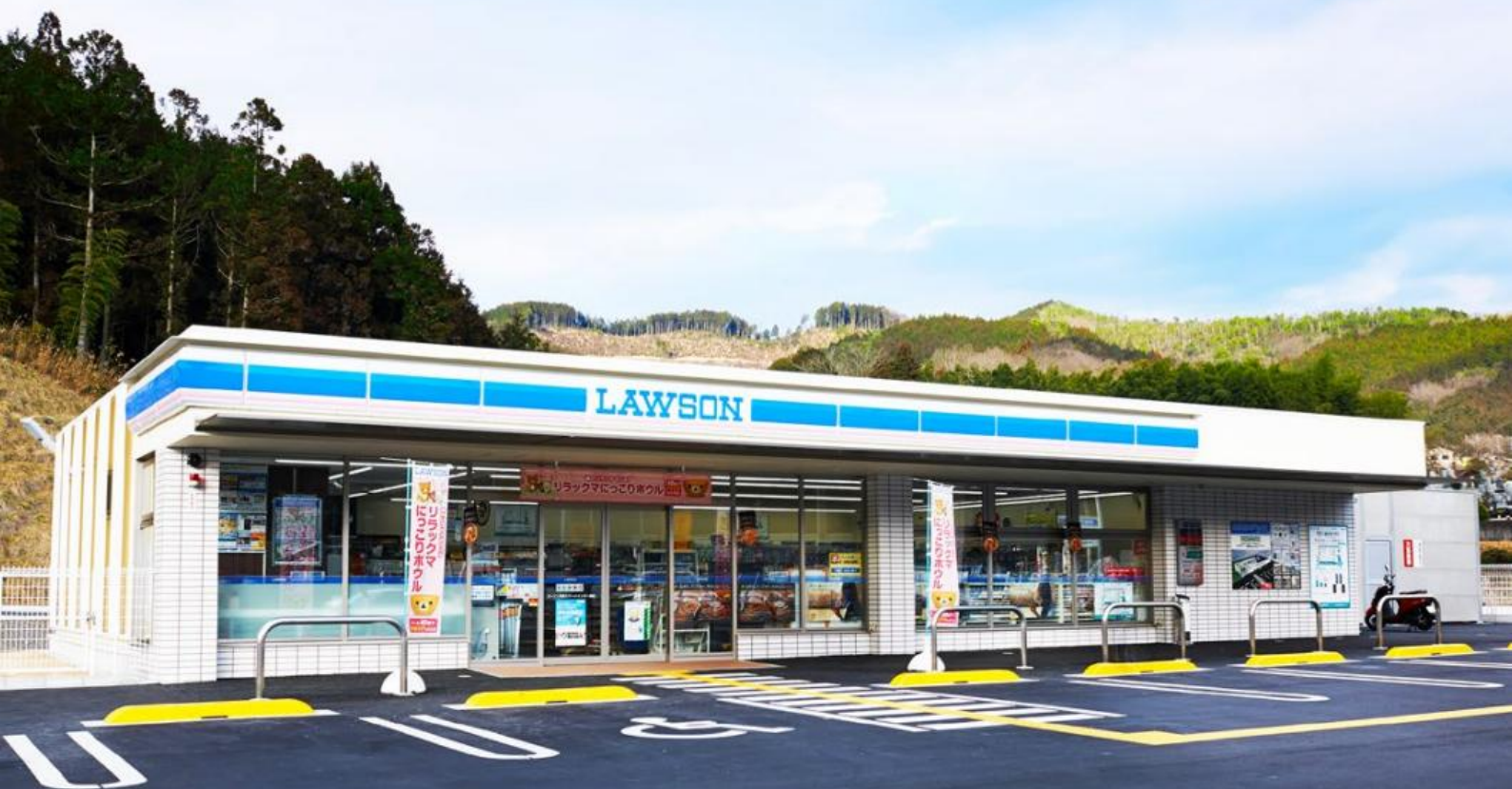
環境配慮モデル店舗 夢前スマートインター前店
